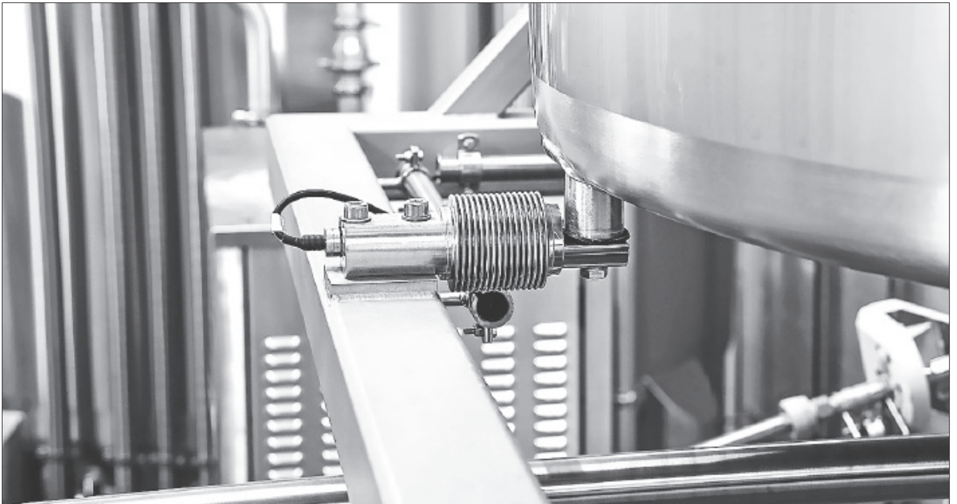
Eilersens vejecelle på tankanlæg. Vejecellen er unik, fordi den måler en kapacitetsændring mellem målefladerne i vejecellen fremfor at måle på et stræk i selve vejecellens materiale.
